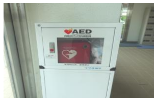
三高小学校・中学校 1階正面玄関
